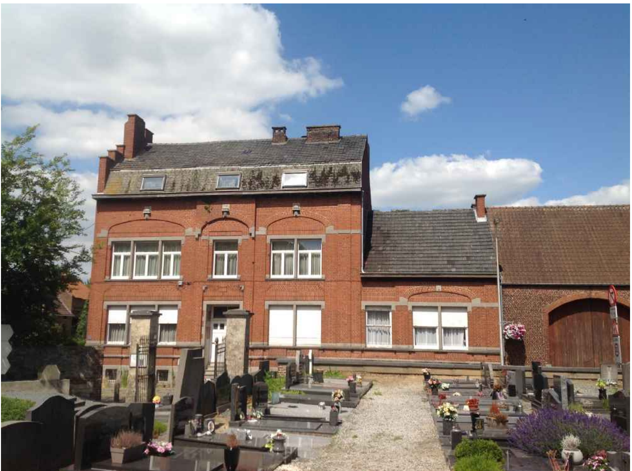
De statige burgemeesterswoning Appelmans in 2019 (foto Luc De Cooman). In 1928 liet Henri Appelmans de oude bouw vervangen door de zakelijk-utilitaire herenwoning die de Bodegemse dorpskern bijna een eeuw zal domineren. De bouwwerken staan op het actief van de Bodegemse aannemer Laurent Plas, uitgevoerd naar de plannen van architect Emiel Van de Weghe uit Jette.
