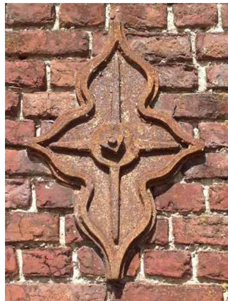
De opmerkelijke muurankers aangewend in de brouwerijvleugel.
